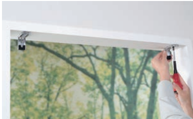
プラスドライバーで「取付けブラケット」を取付けます。
