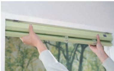
「取付けブラケット」へ製品を取付けます。
