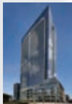
東京ミッドタウン八重洲 八重洲セントラルタワー
