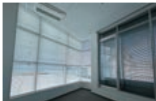
建物の空調・照明一括管理による省エネと快適性の両立
